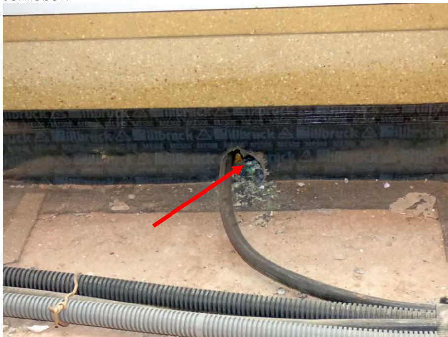
Bild 12 – Kabeldurchführungen durch die luftdichte Abklebung sind fachgerecht zu schließen
