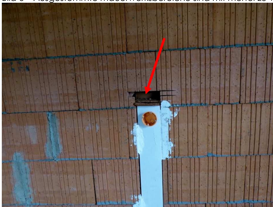
Bild 6 – Ausgestemmte Mauerwerksbereiche sind mit Mörtel zu verfüllen
