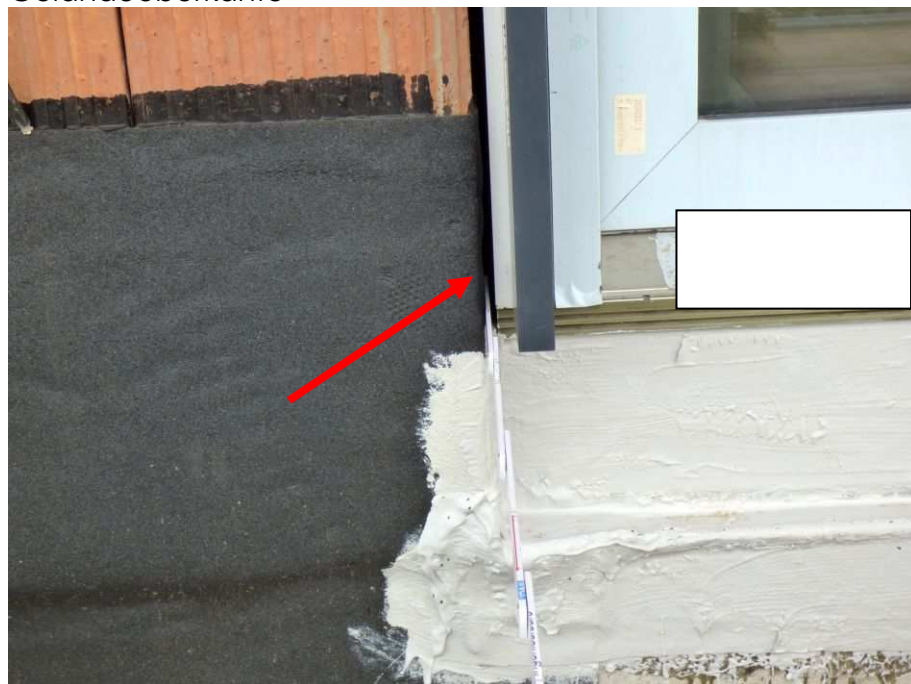
Bild 16 – Leibung ist an die Abdichtung anzuschließen – mindesten 30 cm über geplante Geländeoberkante
