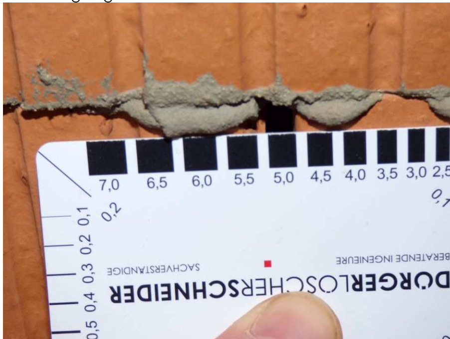
Bild 2 – Fugen größer 5 mm sind zu vermörteln
